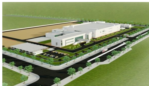
【TERUMO BCT VIETNAM FACTORY PROJECT】
